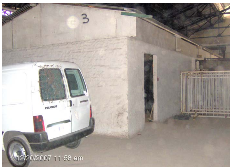
Foto N° 10 – Muro construido dentro del pañol Central.
