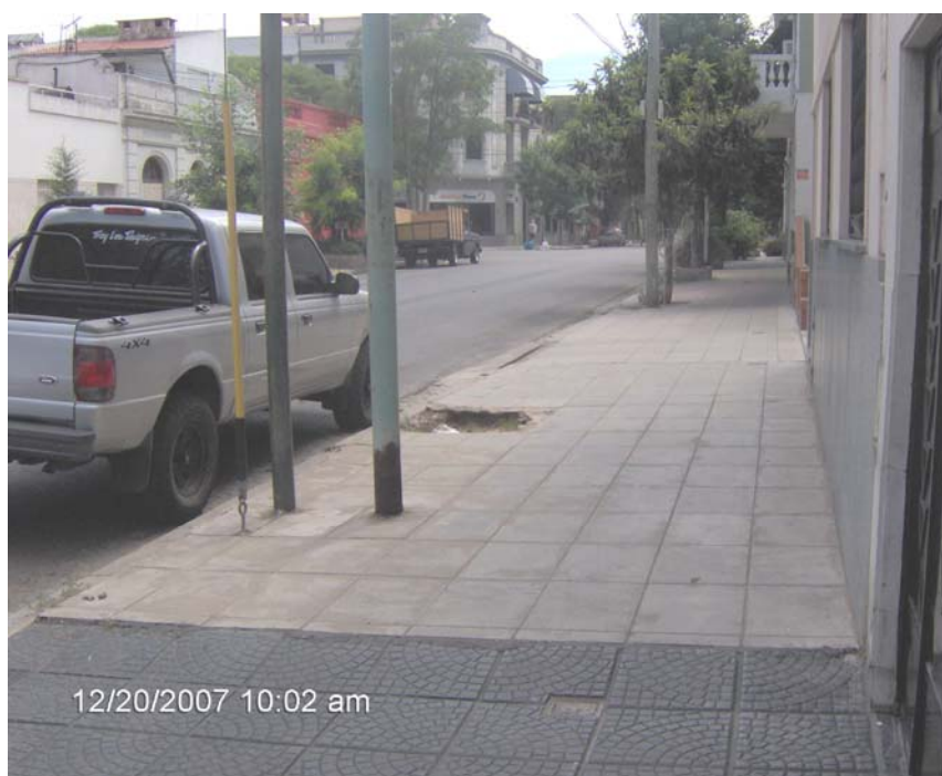
Foto N° 6 - Vereda frente al número 1580 de la calle Arengreen, en el lugar se comprobó la reconstrucción de 30 m2
